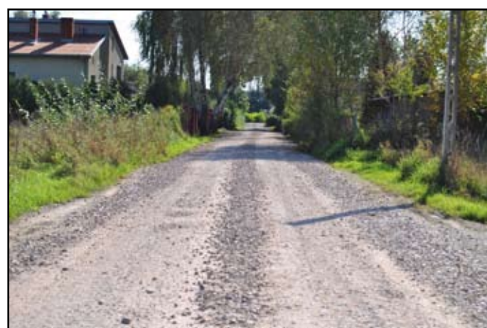
Wzmocniona nawierzchnia ul. Długiej w Rudzie
