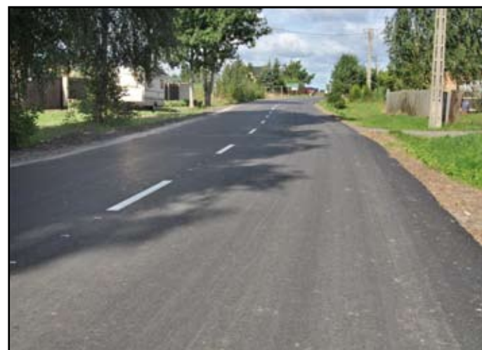
Ul. Piękna w Wola Przypkowskiej po przebudowie
