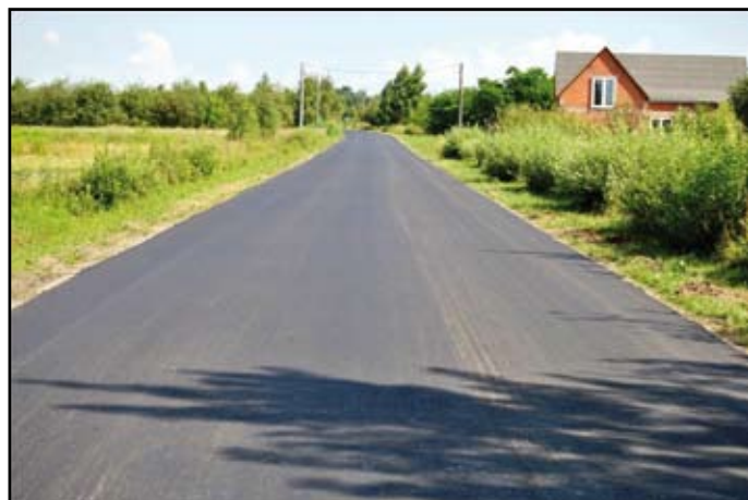
Zmodernizowana ul. Centralna w miejscowości Wylezin
