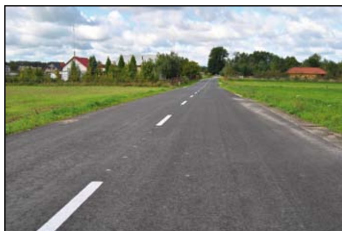
Zmodernizowana ul Polna (Prace Duże – Gładków)
